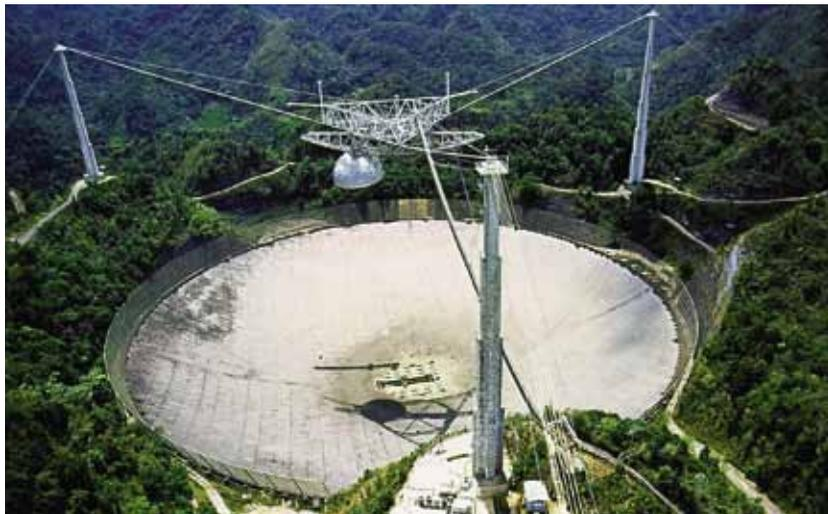
Чаша – это и есть антенна телескопа. Она состоит из 38778 алюминиевых решётчатых панелей, отражающих радиоволны нужной длины, но пропускающих воду и свет: растения, приспособившиеся жить под телескопом, сохраняют почву от эрозии.
