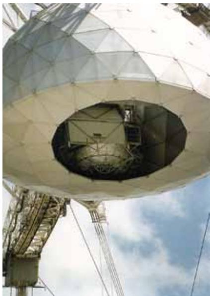
С их помощью высота каждого угла платформы может быть отрегулирована с точностью до 1 мм. Под треугольной рамой платформы расположена конструкция, напоминающая арку моста. Эта конструкция может поворачиваться по кругу, а вдоль арки передвигается необычный купол (см. фото слева) с двумя дополнительными радиозеркалами внутри. Эти радиозеркала перена-
